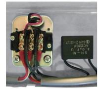
付属のコンデンサをフレームもしくは配線盤に取付けてください。
