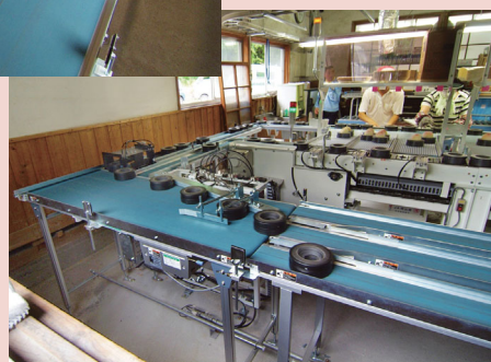
コンベヤには滑りの良い滑性ベルトが装備されています
