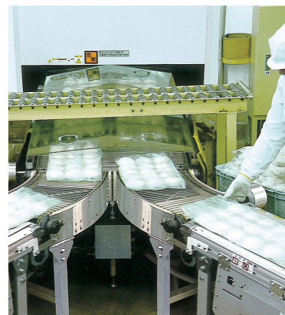
フリーザーの排出コンベヤ
